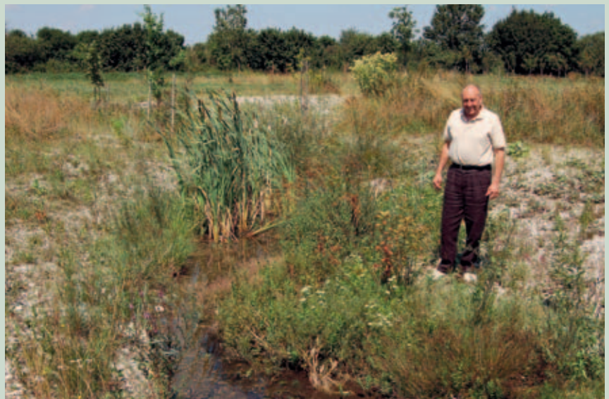
Herr Kraus, der frühere Umweltberater der Gemeinde, vor dem renaturierten Abschnitt der Gleißbach (3. Bauabschnitt)
